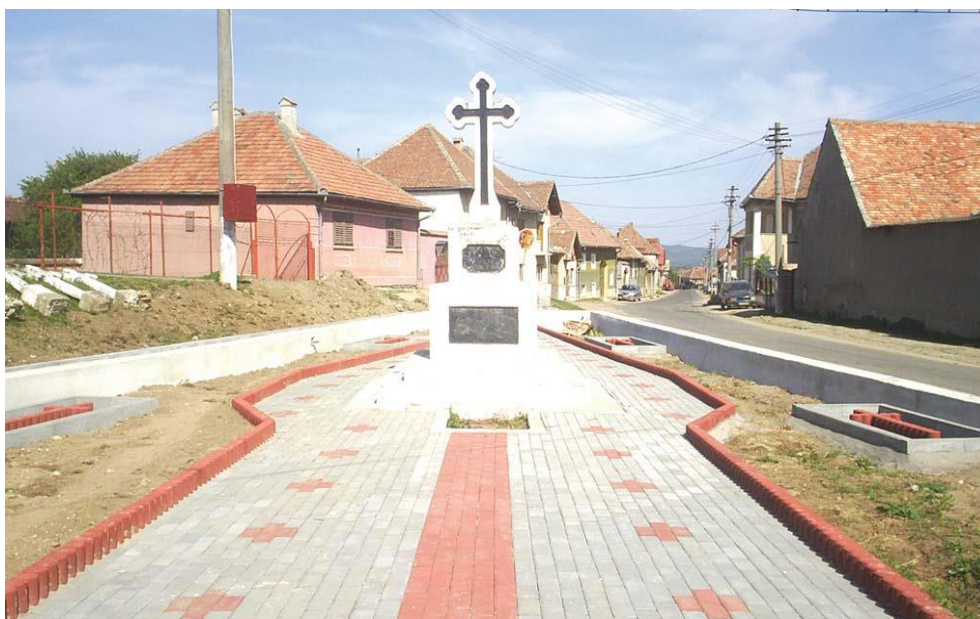
Monumentul Eroilor, ridicat în 1935, în curs de renovare, în anul 2007 ( „InfoSadu”)
