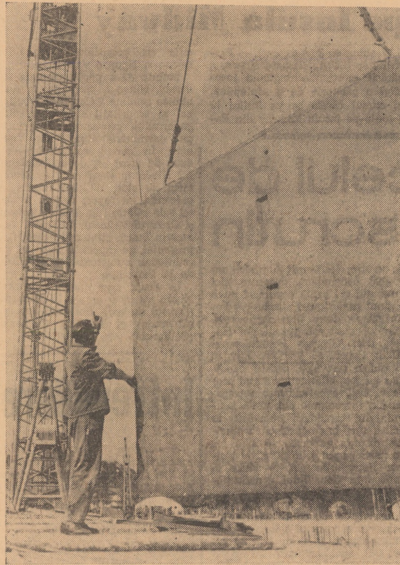
O bună parte a construcțiilor sînt realizate după metode moderne. În fotografie: aspect de la Poligonul de turnare a prefabricatelor
