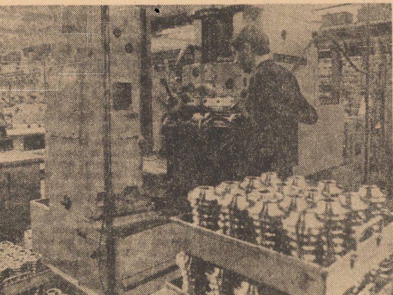
Prelucrarea melcilor pentru mecanisme de direcție folosite la autocamioanele ROMAN-Diesel. Imagine din secția cardane a Uzinei de piese auto Sibiu
