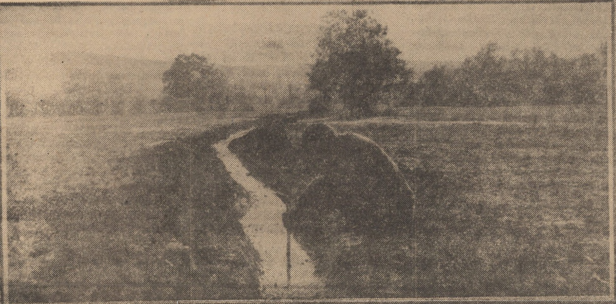
La C.A.P. Bruu, în hotarul „Lunca Mică”, acolo unde a fost un lac provenit din inundații, oamenii au săpat șanțuri, pentru a reda pămînturile circuitului productiv. În fotografie: inginerul Anton Kiraly, urmînd cotele apei în canalele de evacuare
