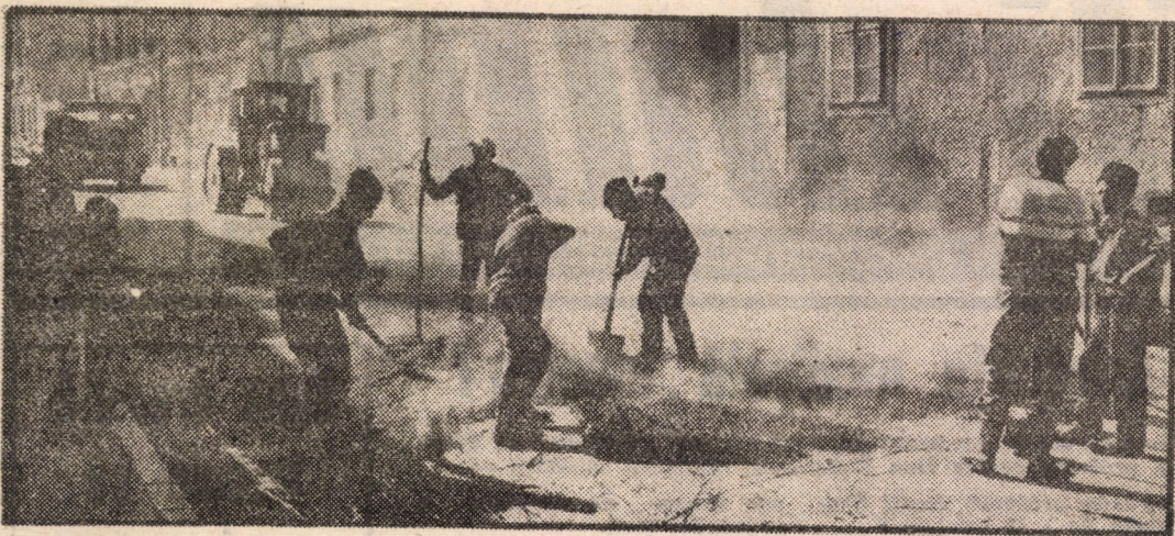
Străzile Sibiului arată, o știm cu toții, dar mai ales... automobilisții, ca după... bombardament. Și iată o veste cu adevărat salutară: pe strada 1 Mai s-a refăcut carosabilul. Așteptăm extinderea acțiunii și pe celelalte artere „bolnave”!
