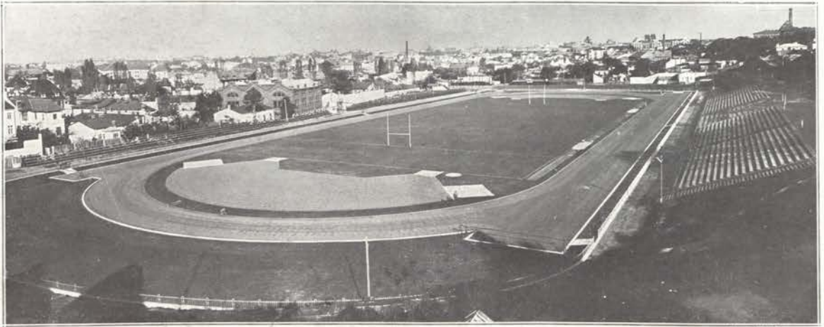
Vue générale du stade de Bucarest.
