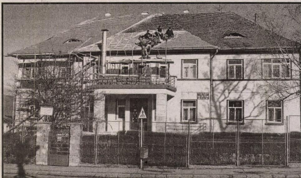
La Secția de Boli Contagioase a Spitalului Clinic de Pediatrie din Sibiu (str. Transilvaniei) după o "cosmetizare" benefică a clădirii, iată - în prezent - se schimbă țiglele de pe acoperiș. În curând, deci, clădirea va arăta conform prestigiului instituției de care aparține.
